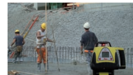
Coladas de hormigón
