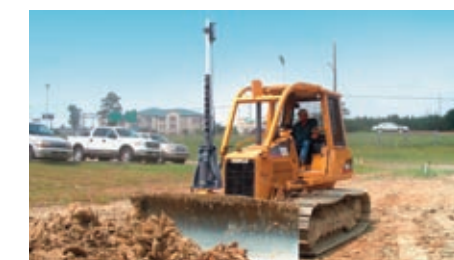
Preparación de proyectos de obras
